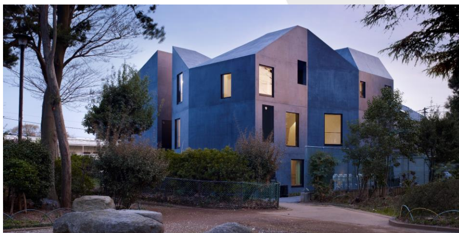
集合住宅「Alp(アルプ)」外観
