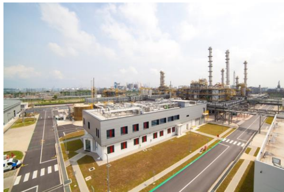
【ランクセスの新ブチルゴム製造プラントの全容】
