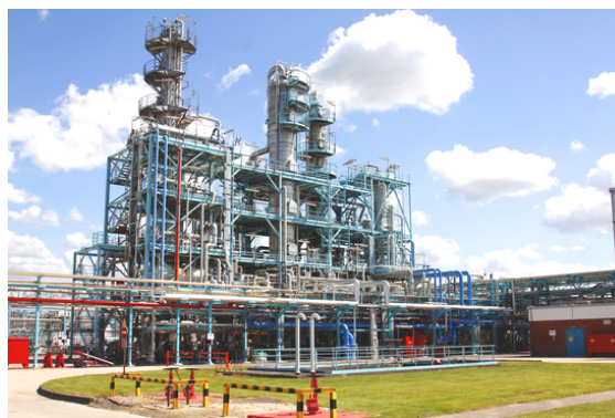
2012 年に 50 周年を迎えたランクセスのポートジェローム拠点。稼働以來、約 1 億バールのゴムを製造
