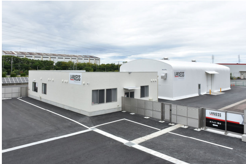
豊橋事業所内に新設された倉庫および品質管理(QC)ラボ棟(写真:ランクセス)
